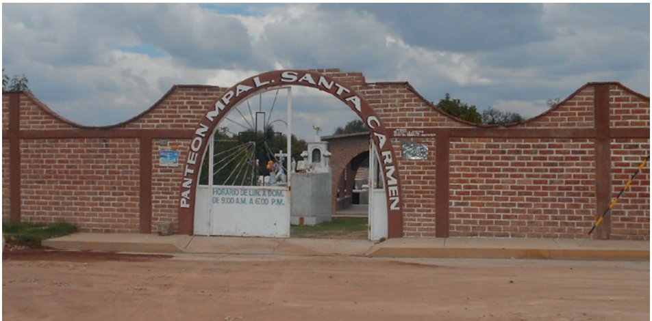
Ilustración 15. Fachada principal del cementerio de Santa Carmen.
