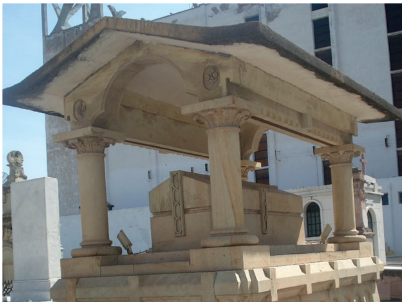
Ilustración 81. Techo del templete del monumento funerario de José Bolado, 1889.
