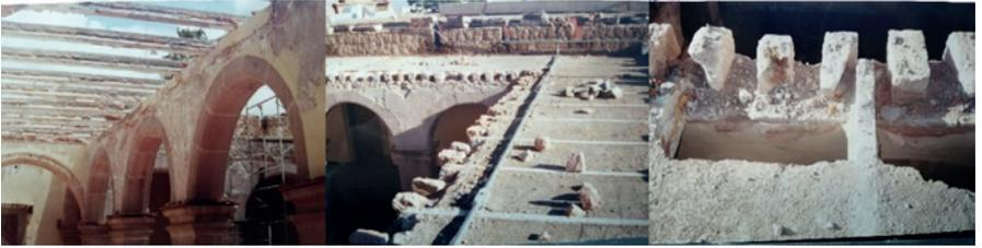
Imágenes 122, 123 y 124. Eliminación de rieles metálicos y bóveda de ladrillo, lo que permitió encontrar los huecos originales de las vigas o “mechinales”, obteniendo su dimensión para volverlas a restituir.
