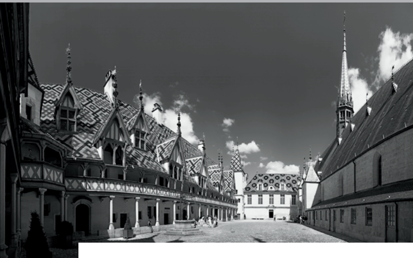
Imagen 2. Patio interior del Hôtel-Dieu.
