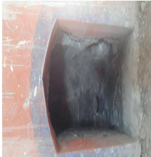
Figura 9. Horno interior de la bóveda (chacuaco). Fuente: fotografía de los autores.
