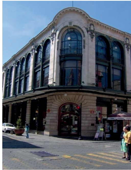
Imagen 11. Vista actual del inmueble. Fuente: Foto del autor, 2009.
