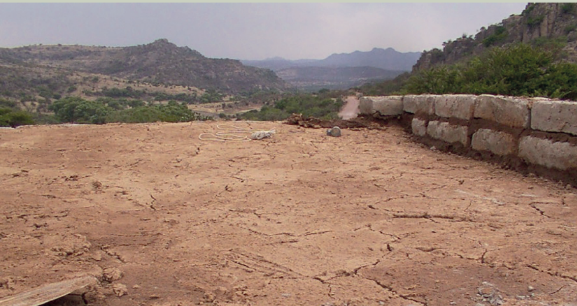
Imagen 13. La última capa del techo de terrado está conformada por tierra compacta que impedirá filtraciones (J. Jiménez)
