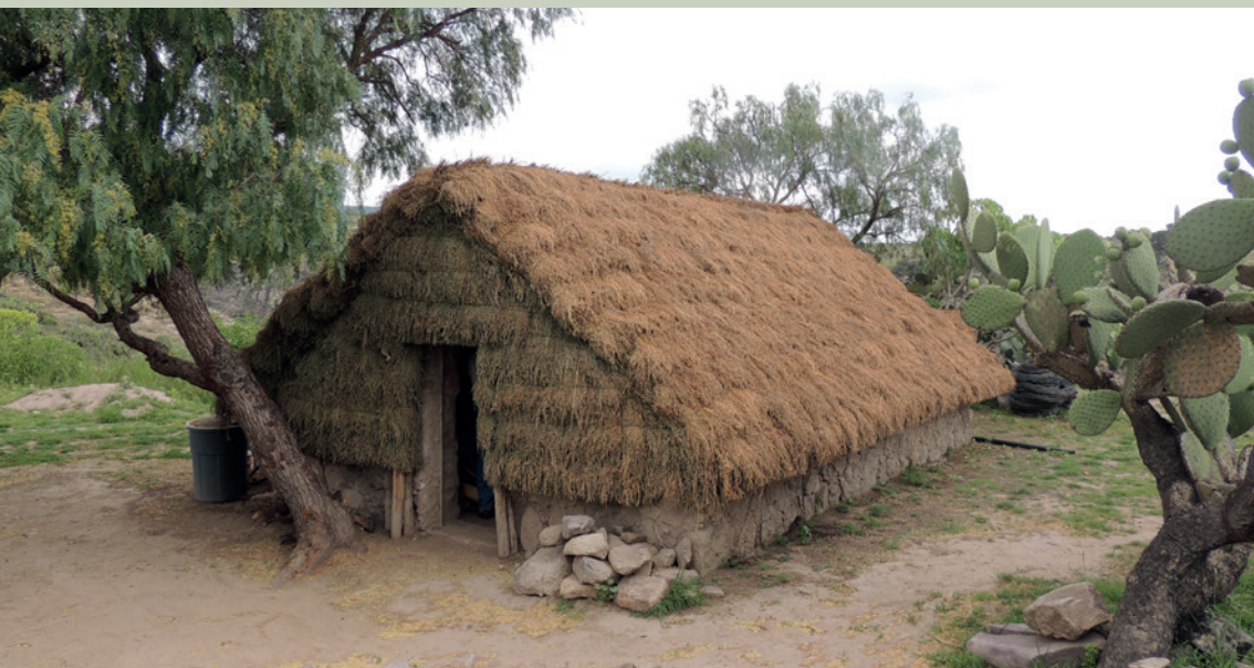
Imagen 10. En comunidades rurales actuales todavía se encuentran construcciones de materiales perecederos, en este caso particular, cimientos y muros de piedra y techo a dos aguas cubierto con ramas de engordacabra en El Cópore, Guanajuato (J. Jiménez)
