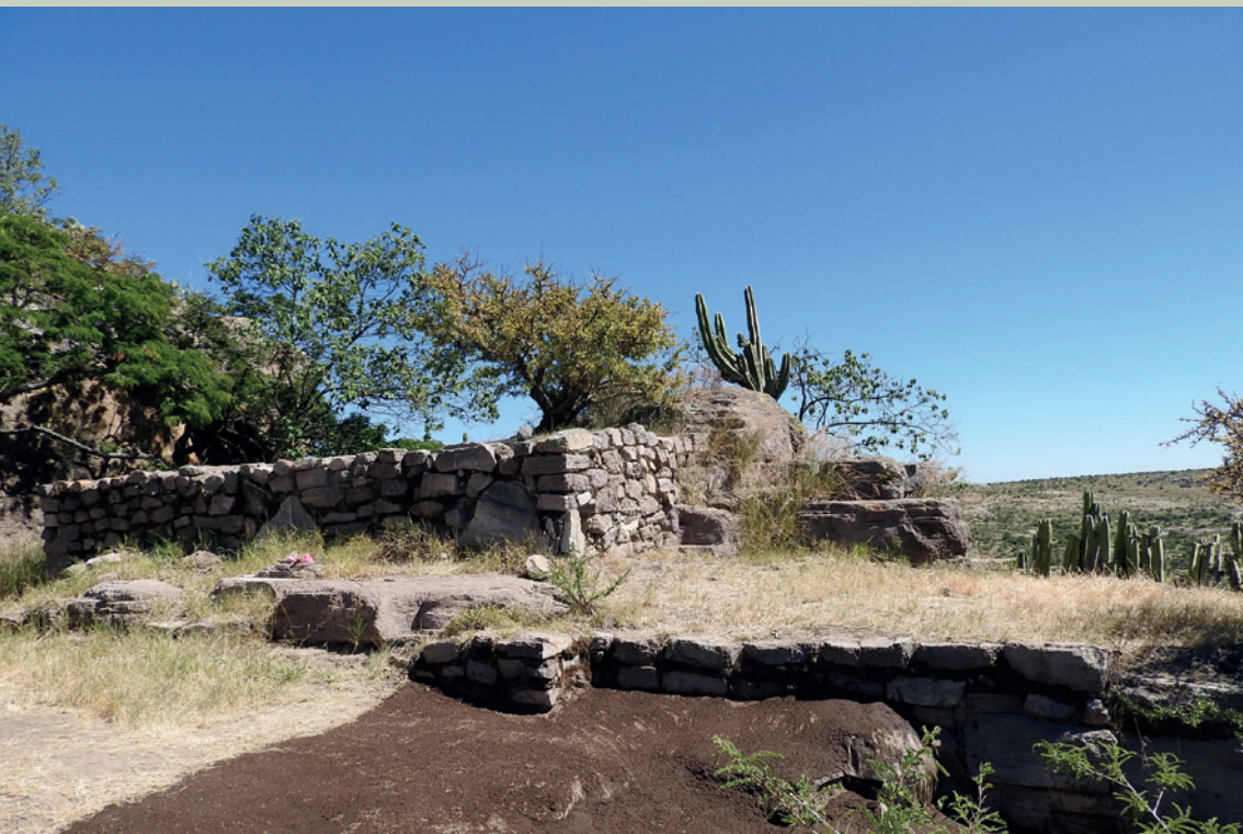
Imagen 1. Estructura ubicada en la cima del cerro, orientada hacia el poniente, construida con la roca local empleando el sistema de muros dobles (J. Jiménez)
