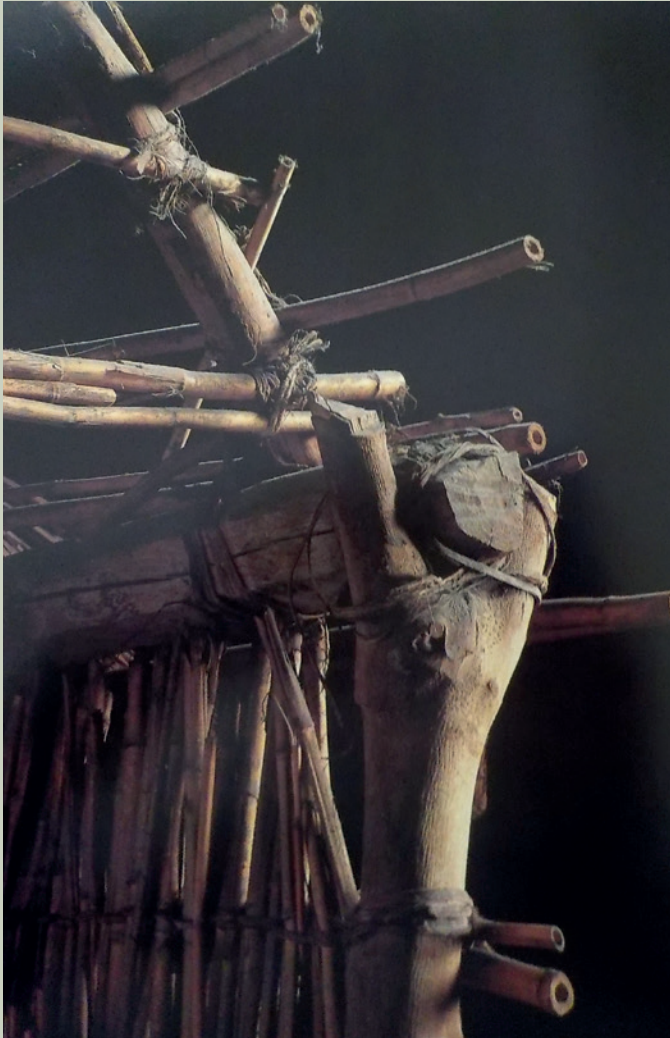
Imagen 11. Armazón construida para sostener la techumbre. En las esquinas del cuarto se colocan horcones en los que se apoya la estructura que dará forma a los techos que a su vez soportarán la cubierta vegetal: palma, ramas, zacate, pencas (Modificada de Matos y Guzmán, 1999)
