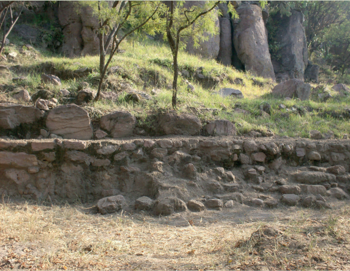
Imagen 3. Muro donde se aprecia la superposición de hiladas de ignimbrita; se pudo identificar un fragmento de enjarre sobre la cara externa, como acabado superficial (J. Jiménez)
