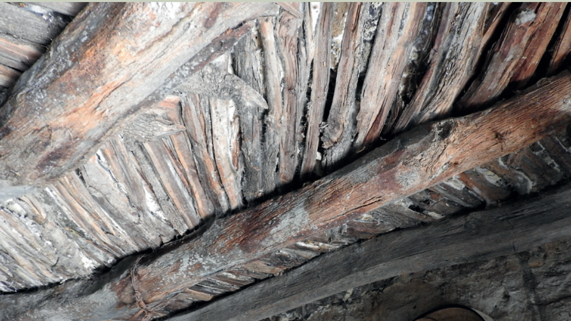
Imagen 12. Para los techos de terrado, se coloca sobre las vigas una capa de tabletas de mezquite que se cubrirá después con tierra (J. Jiménez)
