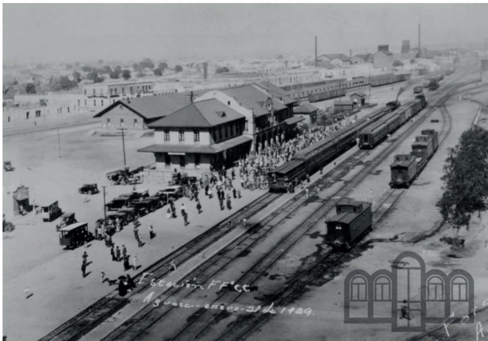
Figura 3. Vista de la estación de pasajeros antes de la construcción del jardín del mismo nombre.
