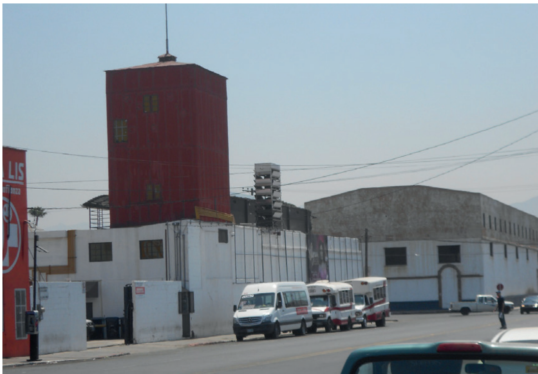
Figura 3. Bodegas de Santo Tomás, junio de 2017, vista desde la Calle Sexta y Avenida Miramar Fuente: Fotografía del autor.
