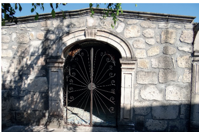
Figura 5. Capilla de la Ex hacienda de El Colegio en el municipio de Tarímbaro. Fotografía del autor.
