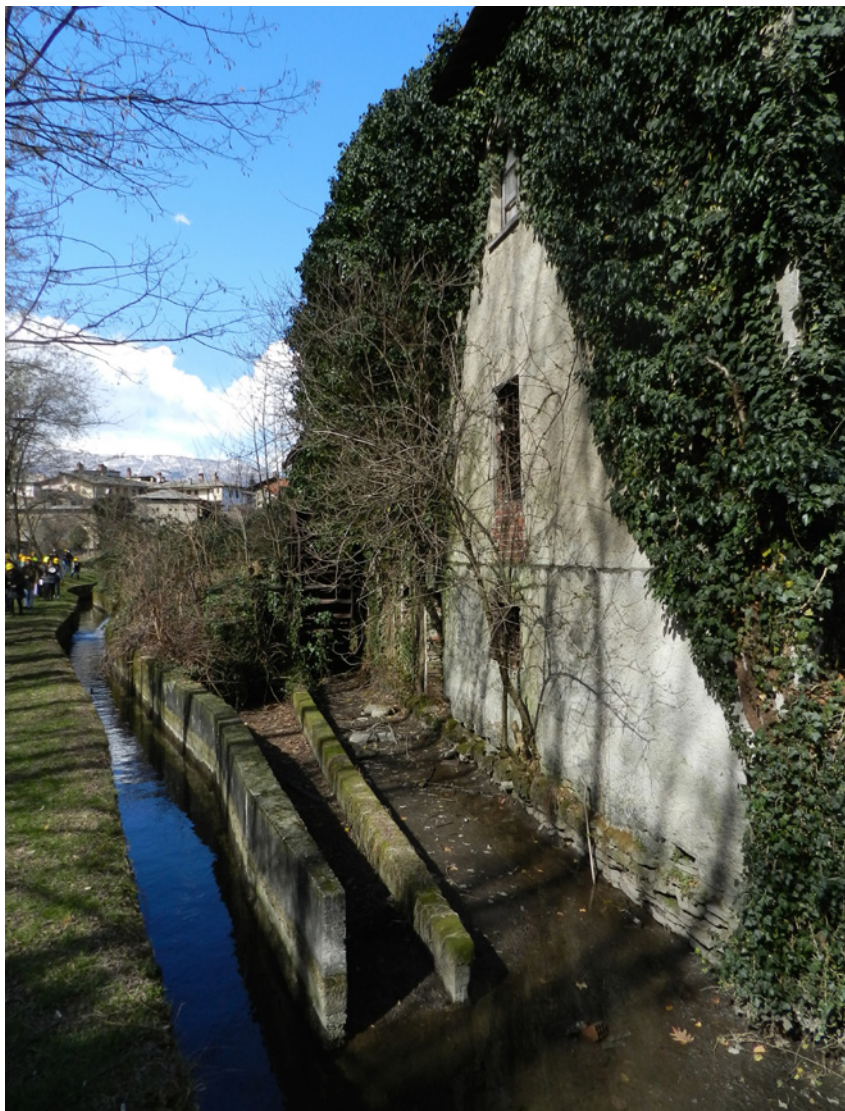
Fig. 2. Mulino Colombatto, Barge (Torino, Italia). Il canale e la ruota utilizzati per sfruttare la forza motrice dell'acqua per garantire il funzionamento dei macchinari presenti nell'adiacente falegnameria (foto Manuela Mattone).
