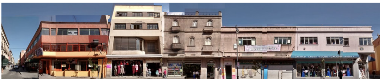
Figura 6. Las fachadas arquitectónicas comprendidas por el tramo de las calles José Ma. Morelos y Pavón y Gral. Mariano Escobedo, presentan discontinuidad tanto en materiales como en alturas y estilos.
